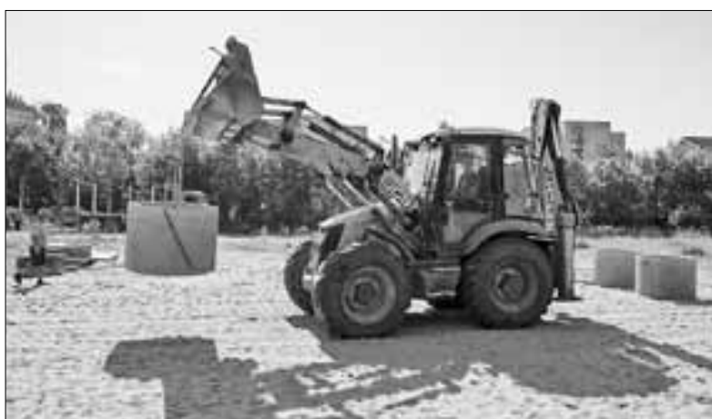
■ На ул. 23-й Гвардейской Дивизии идет подготовка территории к строительству парка
